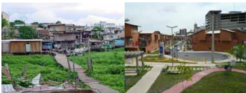
Fotos 1 e 2 - Igarapé Manaus: condições de moradia e pontes de madeira que interligam as palafitas, antes e depois da intervenção do Prosamim.
